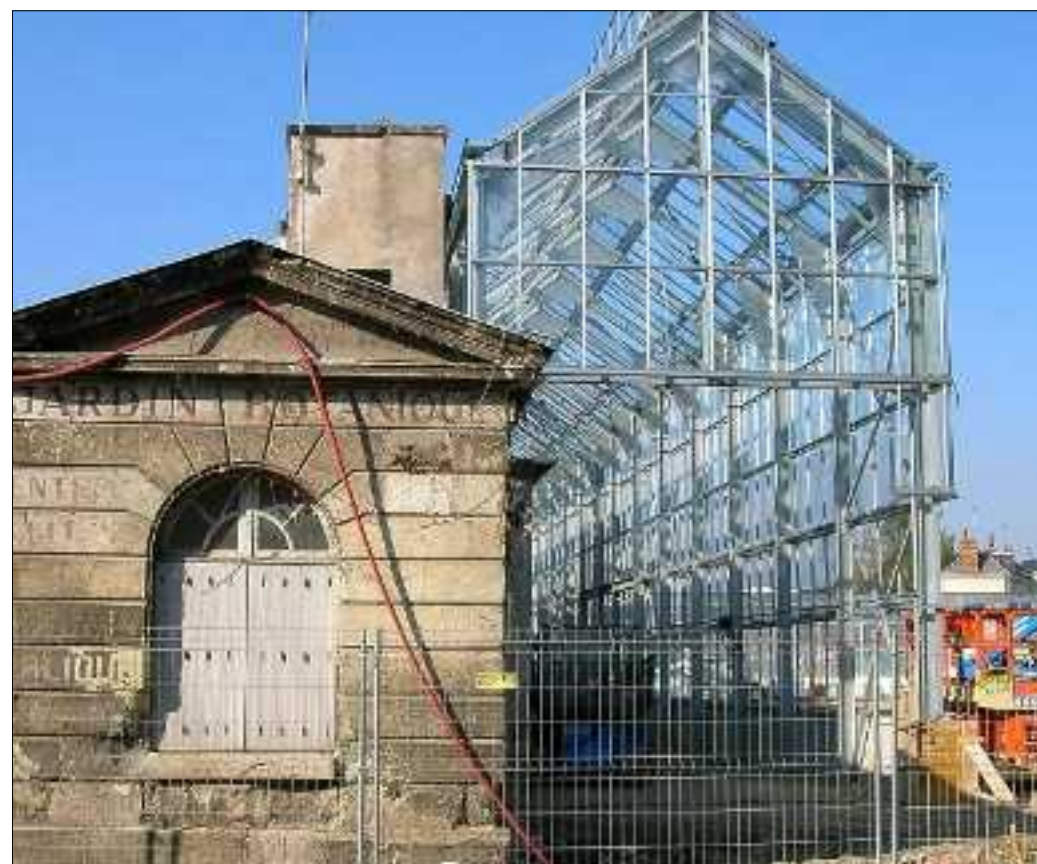
La nouvelle serre en construction.
