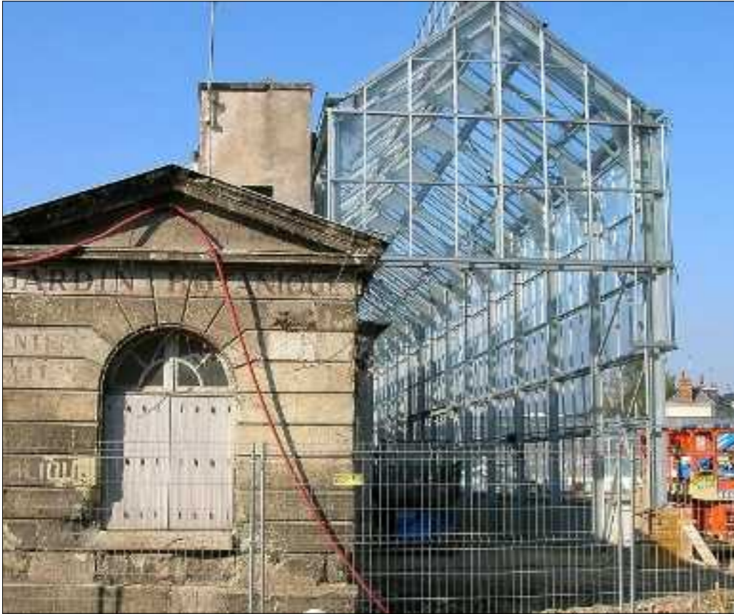
La nouvelle serre en construction.
